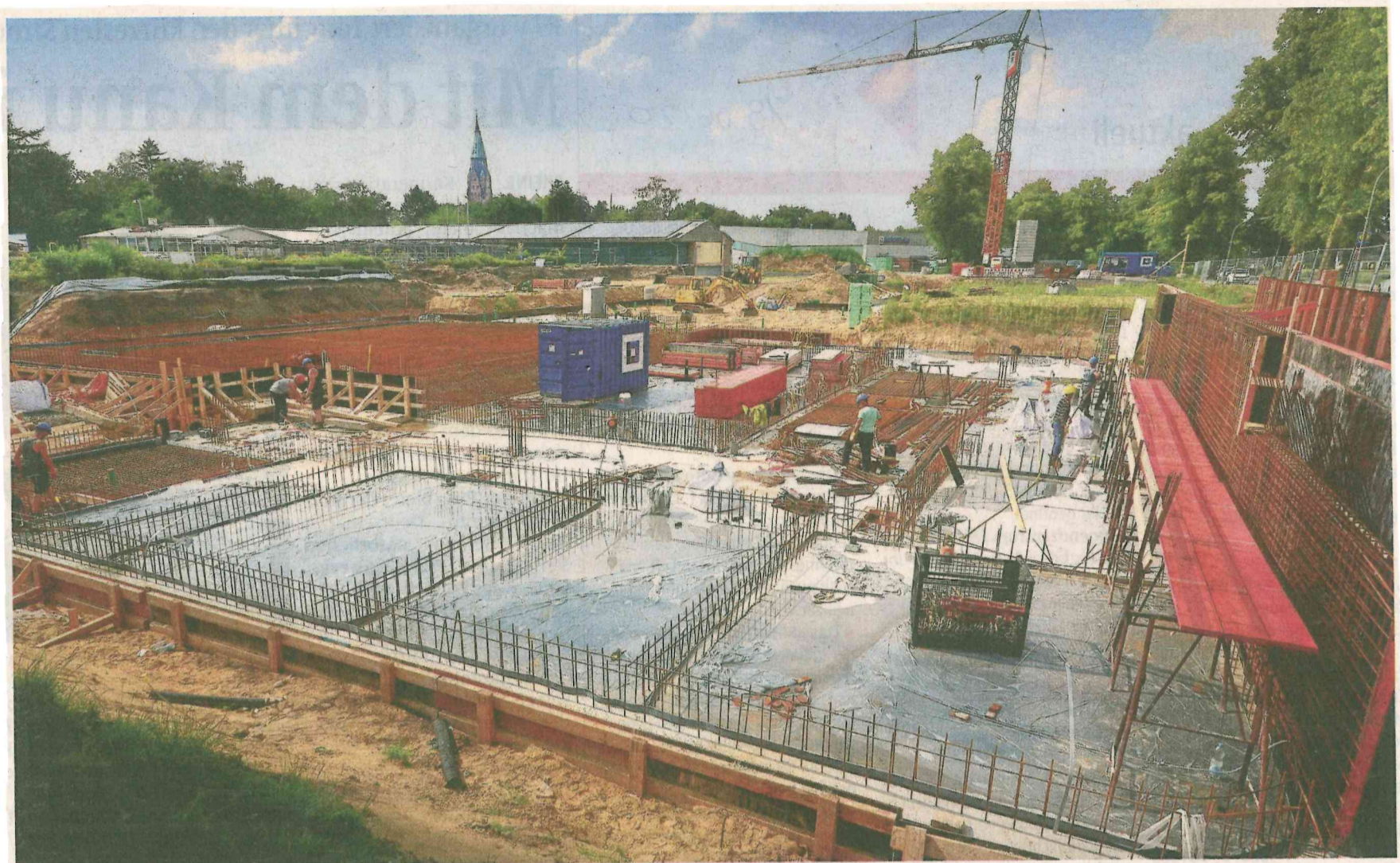
Aktuell wird im neuen Kombibad Rheine die Bodenplatte gegossen.
